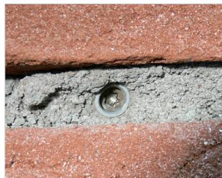
La fixation peut être posée dans le joint couchant.
