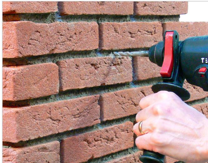
Forez en un mouvement un trou de 8 mm à travers la maçonnerie extérieure jusqu'à la bonne profondeur dans la maçonnerie intérieure.
