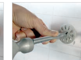
Inslaan van het lijmanker d.m.v. het inslagpijpe.
