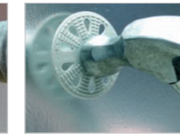
Plaatsen van de isolatieplug. Isolatie is nu windvast gefixeerd.
