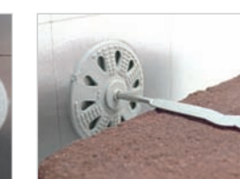
De buitengevel kan nu verder opgebouwd worden.
