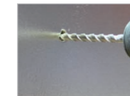
Boren in de gevel ter hoogte van de lintvoeg.
