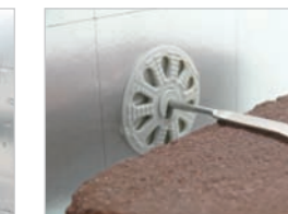
De buitengevel kan nu verder opgebouwd worden.
