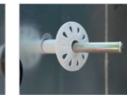
Sla de plug volledig in met behulp van slagpijpe.
