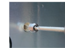
Boren met diameter 8 mm met isolatie/freesboor.
