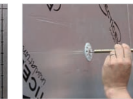
Inslaan van het spouwanker d.m.v. het slagpijpe tot aan de schotel.
